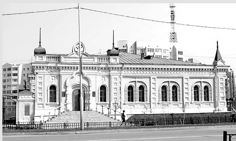
Реставрация Дома казначейства (1909 г., архитектор Браунгартон, расположен по адресу: г. Якутск, Петровского, 4) оценена в 65,9 млн рублей.
